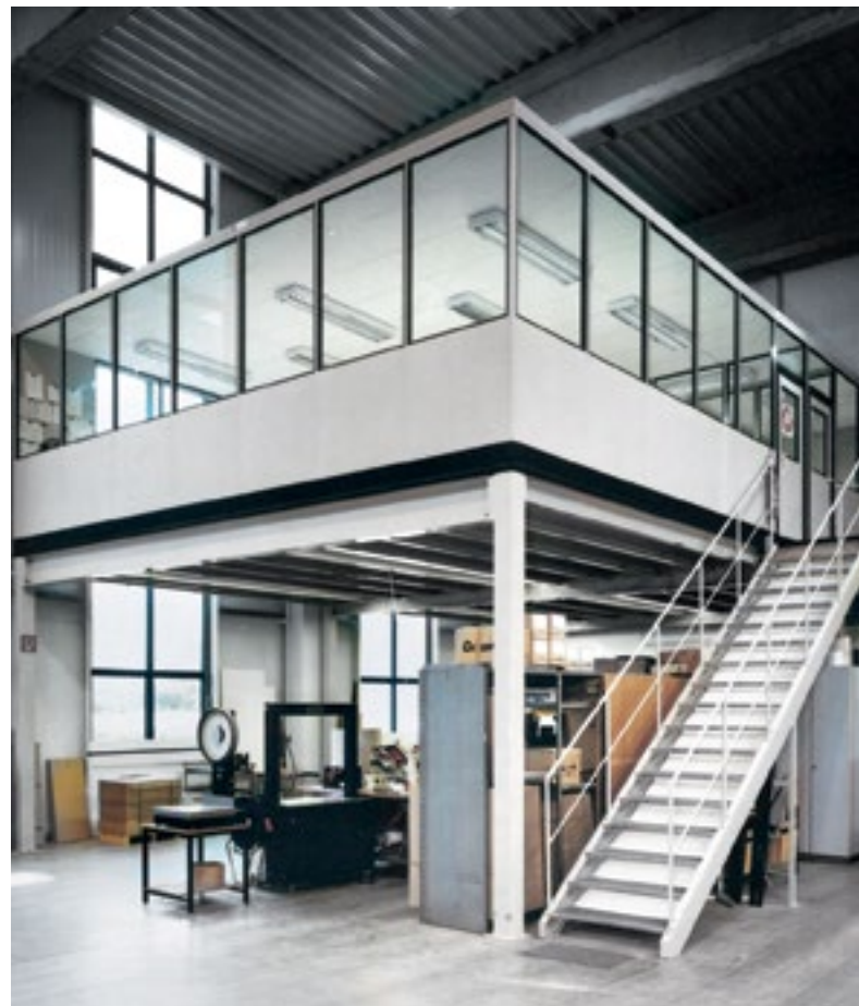
Lagerbühne als Unterbau für ein GEMAC-Hallenbüro
