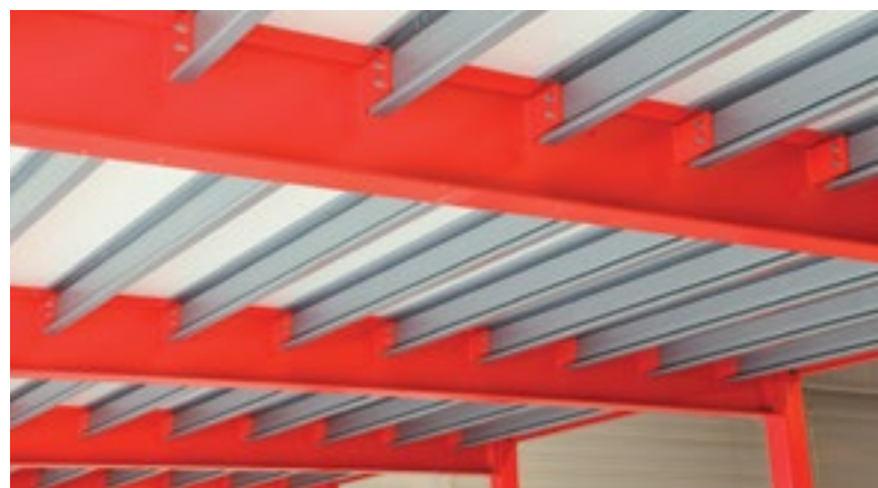
Detailfoto: Bühnenträger aus verzinkten Sigma-Profilen
